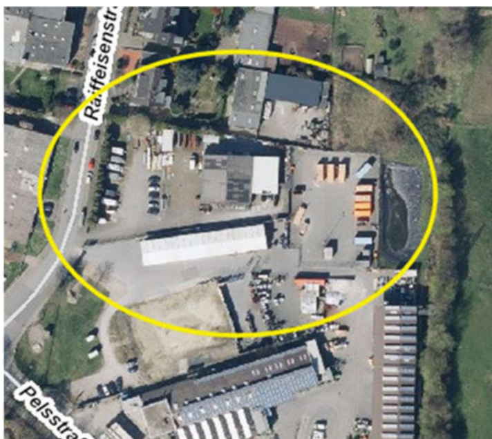
Bild 1: vorhandene Grundstückssituation Quelle: googlemaps
